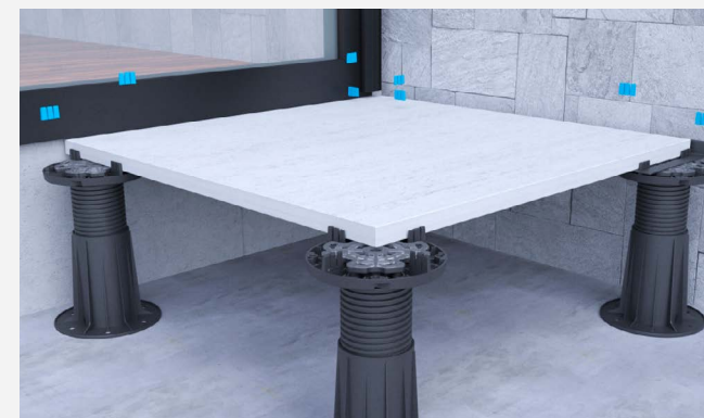
1º Colocación de piezas de perímetro
